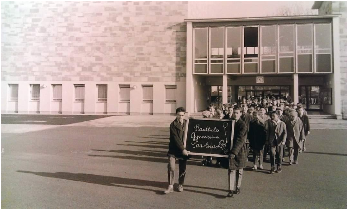
Umzug des Saarlouiser Gymnasiums vom Prälat-Subtil-Ring 2 zum Neuen Gymnasium am Stadtgarten 1 im Jahre 1960. Die geräumige Hausmeisterwohnung befand sich hinter jenen acht Fenstern linker Hand. (**)
